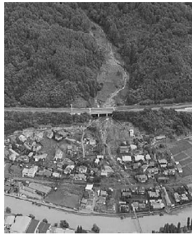
平成18年7月豪雨(20060718) 長野県岡谷市 中央自動車道
