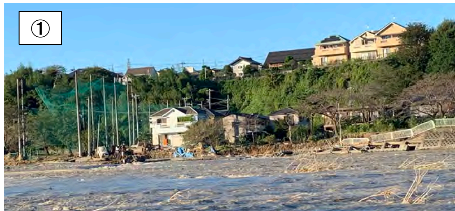
護岸の損壊、家屋への浸水（13日撮影）
