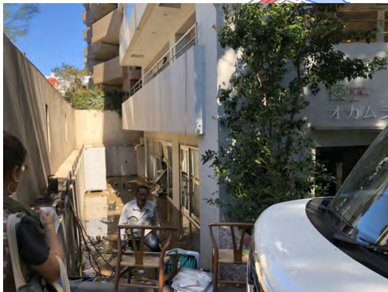
浸水したアパートの台風翌日 13日昼の様子。 泥水が地下に残っている。 (筆者ら撮影)
