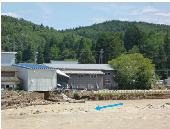
破堤地点に位置した倉庫
