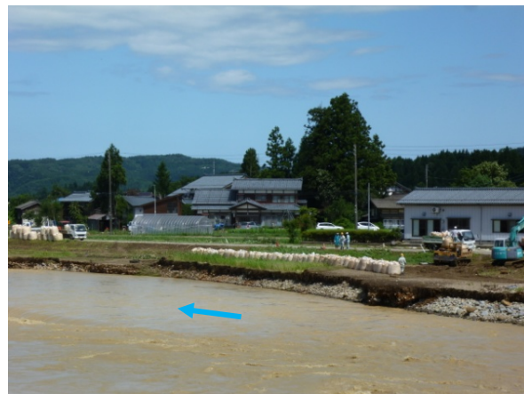
破堤地点の洗掘の状況
