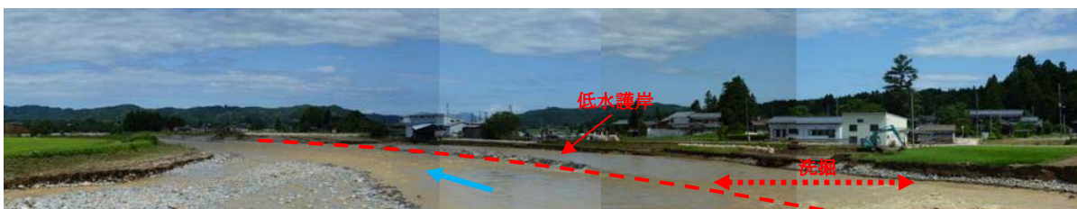
橋梁の上から破堤地点(右岸側)を望む
