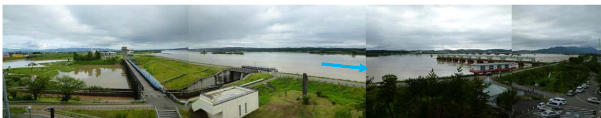
大河津分水資料館屋上より信濃川を望む
