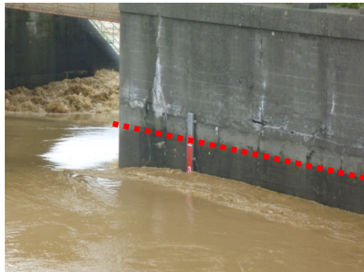
可動堰脇の水位標(赤：痕跡)
