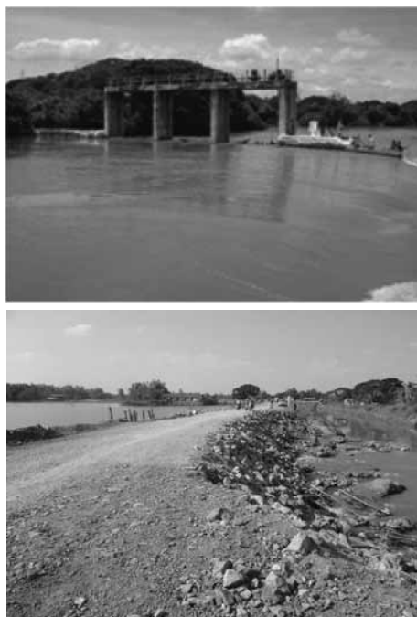
写真2 チャオプラヤ川下流域左岸側の破堤箇所の写真（11月中旬に撮影）左：破堤した8カ所のうち2カ所が水門だった。右：写真の左側がチャオプラヤ川で右方向に破堤した。
